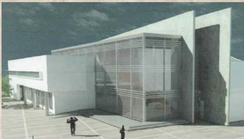
Nueva biblioteca y aulas FIGMM (en construcción)
