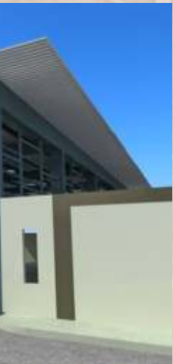
Laboratorios de ventilación, seguridad, mecánica de rocas, maquinaria y software para minería FIGMM (en construcción)
