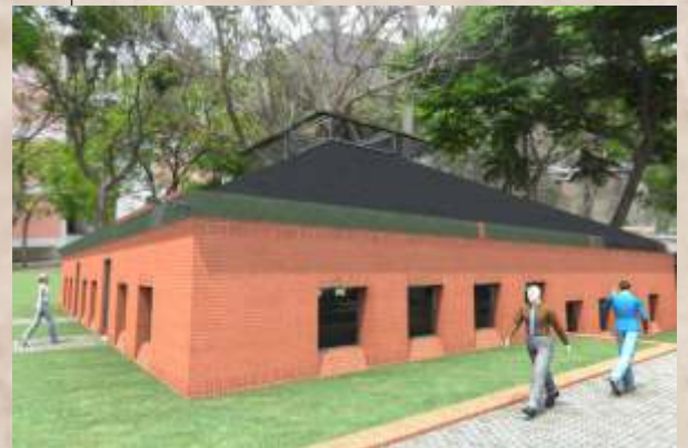
Comedor para estudiantes residentes (en construcción)
