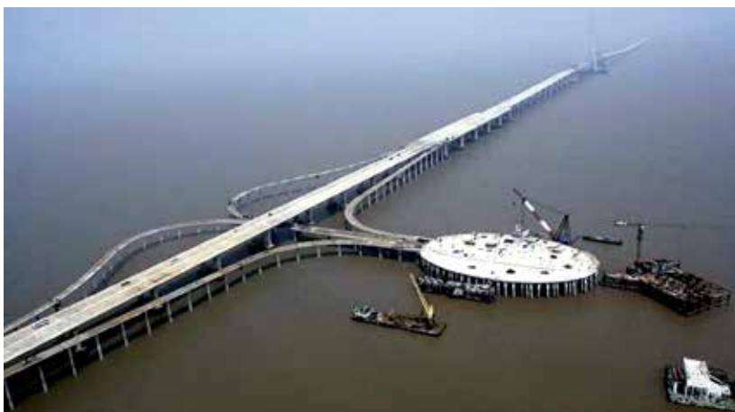
Entre los puentes transoceánicos más largos del mundo. En el 2011, luego de cuatro años de construcción, se inauguró un colosal puente de 41,58 kilómetros, que une los dos extremos de la Bahía de Qingdao en la provincia de Shandong. El puente, diseñado para soportar terremotos, tifones y colisiones de barcos, tiene más de cinco mil pilotes y dispone de seis carriles con un total de 35 metros de ancho.
